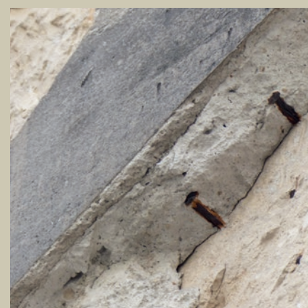
Enduit d'une courette rue St Jacques, Paris (Photographie Tiffanie Le Dantec)
