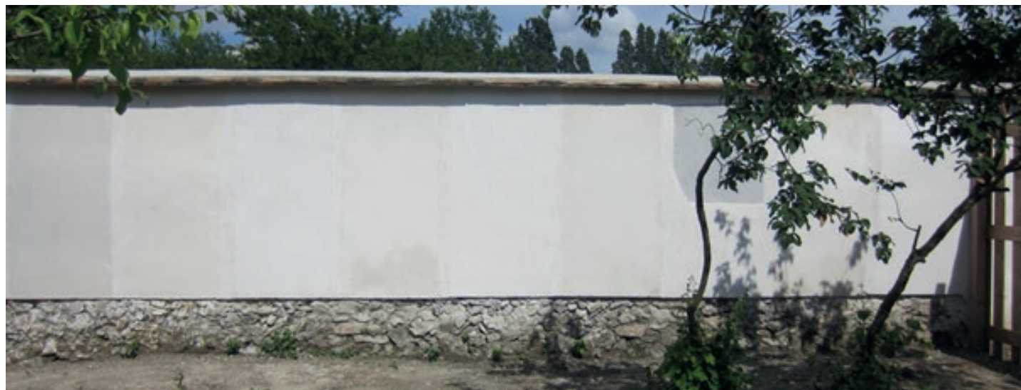
Haut : Illustration des enjeux de conservation/restauration de façades en plâtre remarquables, 22 rue Geoffroy l'Asnier avec enduit d'origine (1675). Milieu : Décor en plâtre nécessitant une consolidation matricielle, Hôtel des Ambassadeurs de Hollande, Paris (crédit : Véronique Vergès-Belmin) Bas : Le mur d'essai avec les différents enduits sur le site des murs à pêche à Montreuil.
