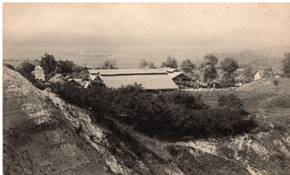
◀La plâtrière de Montigny exploitée par la Société des Plâtrières Réunies du Bassin de Paris. Elle est implantée au pied de la carrière à ciel ouvert et souterraine. A l'horizon, la vallée de la Seine. Carte postale, début du XX e siècle, archives du Musée du Plâtre.
