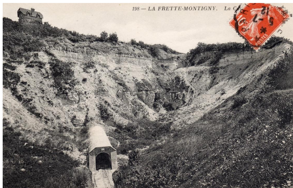
◀La carrière à plâtre de la Société des Plâtrières Réunies du Bassin de Paris. A Montigny. De l'ancienne carrière à ciel ouvert, un tunnel permet d'accéder à l'exploitation souterraine. Carte postale, début du XX e siècle, archives du Musée du Plâtre.
