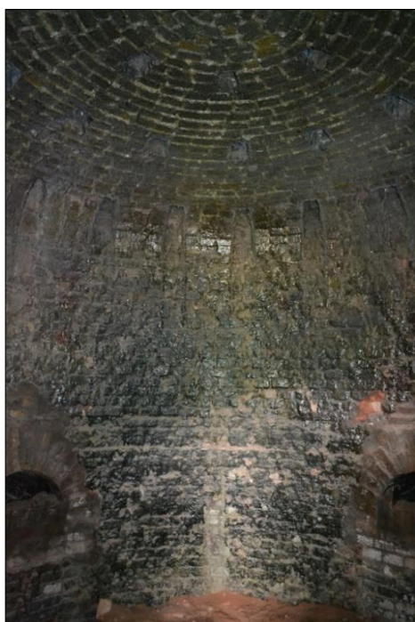
► Intérieur du four à grès au sel, un des deux fours situés dans le bâtiment principal de la poterie.
