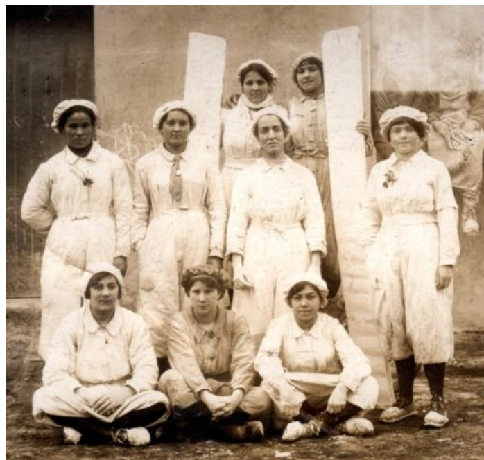
► Femmes travaillant à la fabrication des planches de plâtre chez Lambert pendant la guerre de 1914-1918 (détail). Archives du Musée du Plâtre.
