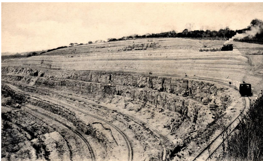
► La carrière de Cormeilles dans les années 1910, étagée de gradins selon les matériaux exploités, et sillonnée par les chemins de fer à vapeur sur voie étroite. Archives du Musée du Plâtre.
